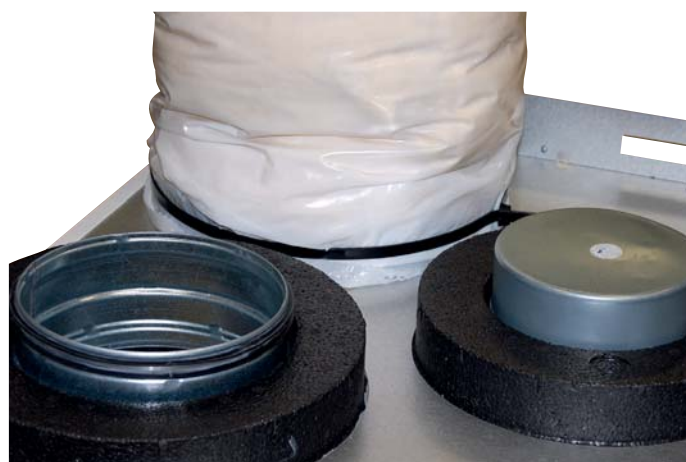
Ferdig montert kanal.
