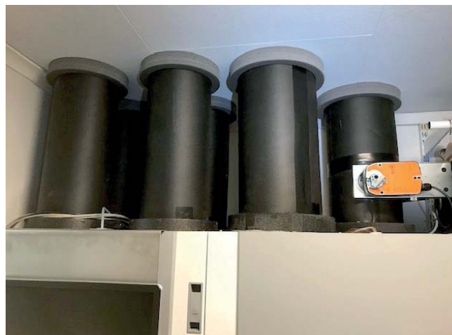
Cellegummiisolerte kanaler
